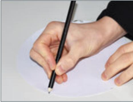
1. Schneiden Sie, wenn Sie eine geeignete Position für die Antenne gefunden haben, die mitgelieferte Schablone aus. Nutzen Sie die Schablone, um die Position der Zentrierbohrung (25 mm Durchmesser) auf dem Dach zu markieren.
