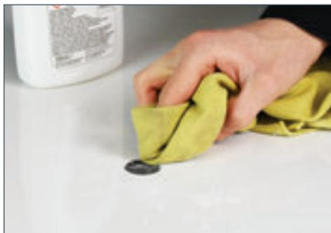
5. Reinigen Sie die Fläche, an der die Antenne montiert wird, und vergewissern Sie sich, dass sie schmutz- und fettfrei ist.
